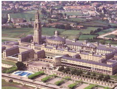
Supervisión control de Instalaciones
